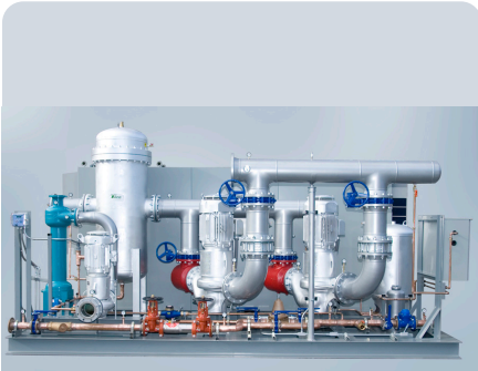
Data Center Las Vegas, Nevada
